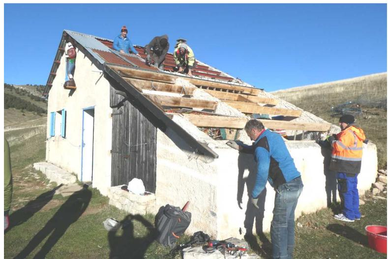
métallique à l'aide de vis auto-perforantes. Et ainsi de suite, arrête faitière, abergement de cheminée, rives, à 16h30 le toit est réalisé. Les ouvriers se rassemblent pour la photo souvenir. Il est temps de descendre le froid arrive et la nuit tombe.
