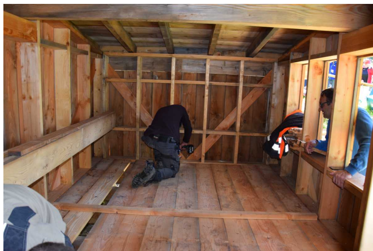
Une cabane, inaugurée le 17 mai 2025, a été construite pour servir d'abri aux randonneurs.
